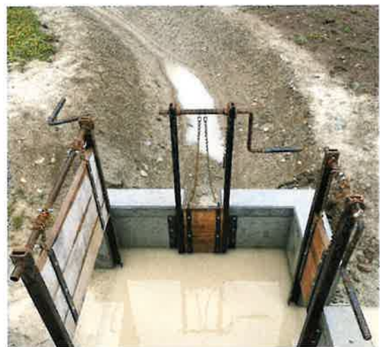
«Brütsche» (= Verteilanlage)
